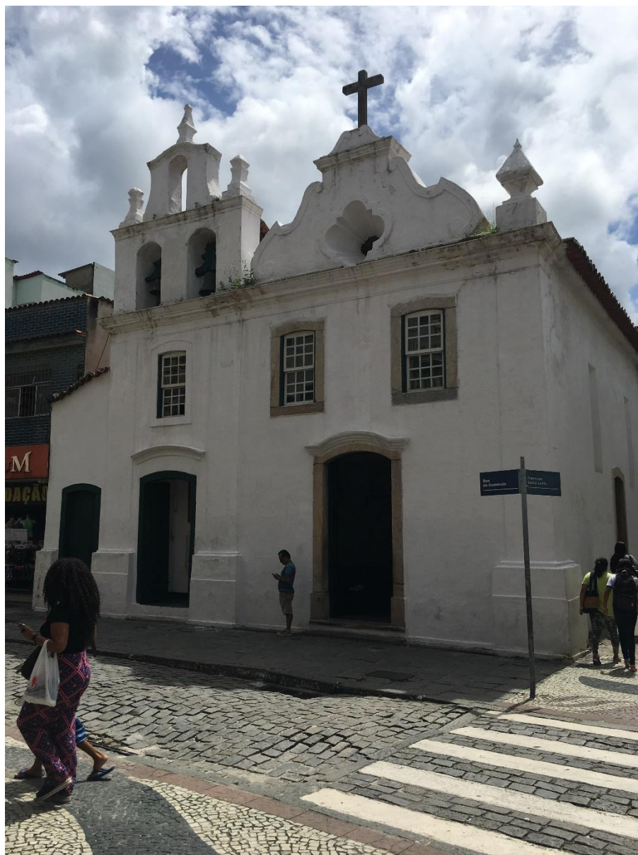
Figura 20 – Fachada da Igreja de Santa Luzia
