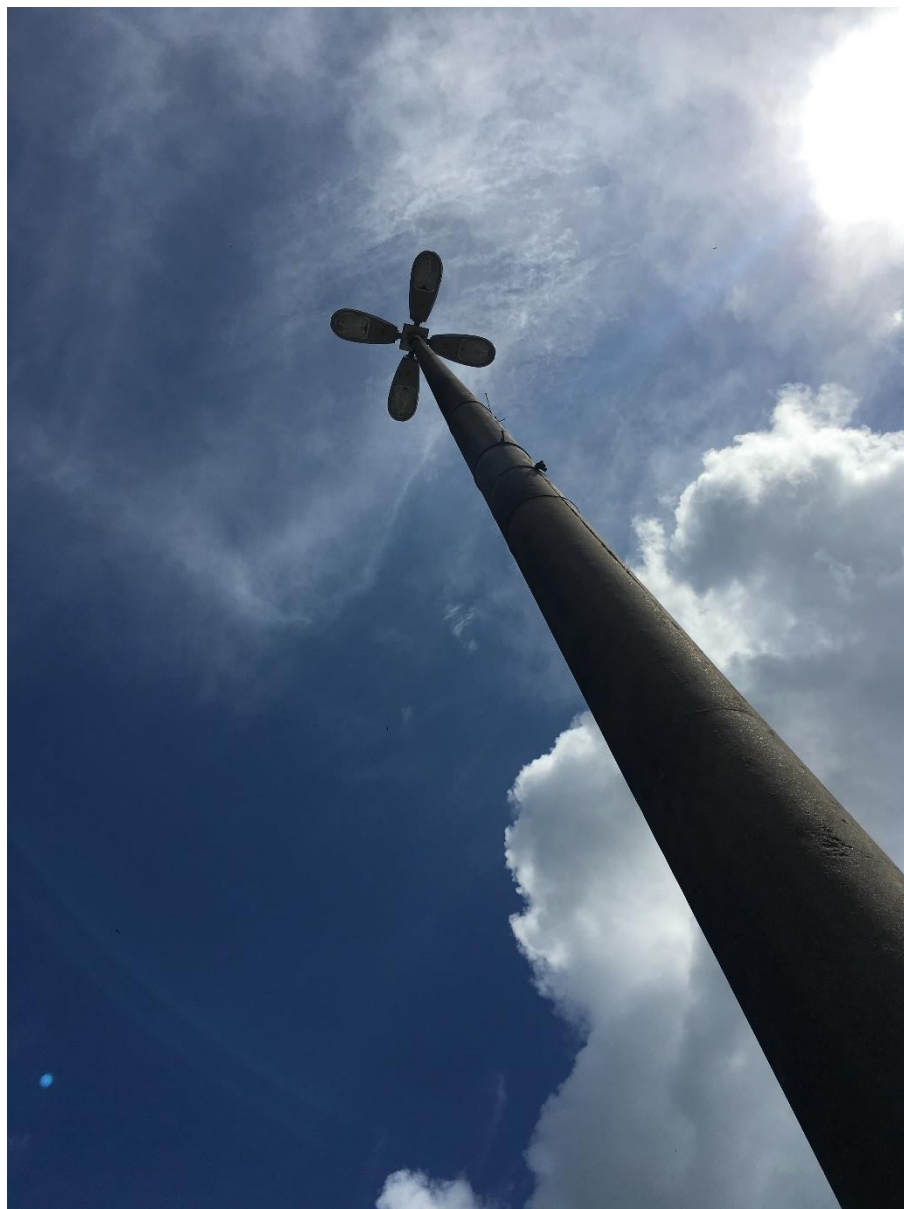
Figura 8 – Suporte 4 Luminárias – Av. Oswaldo Neves Martins (Centro)
